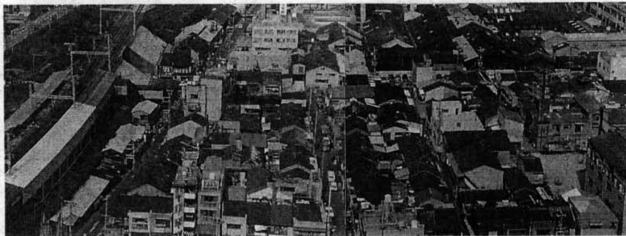
写真1 戦前長屋の地区（延焼した新長田駅南の北東側、1979年撮影） 上側の工場群は震災前に耐火建築物となっており、延焼していない。 手前側の長屋群は全焼した。この中に写真2右側の防火壁があった。
