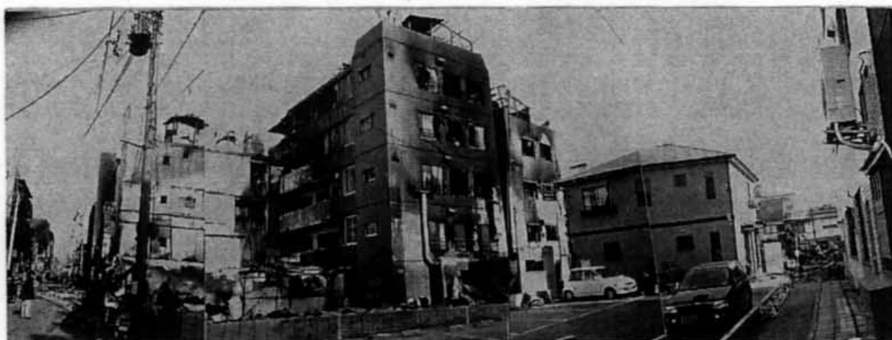
写真4 焼失直後の西代市場周辺の西端（1995年1月28日、建築研究所調査団撮影） 写真3の中央の耐火造及びその周辺の木造家屋が焼失している。右側通路奥は焼失しているが、その手前の新しい戸建て住宅は防火構造などが貢献し焼け残った。
