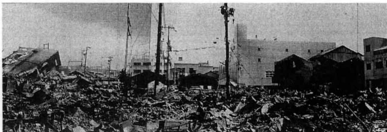
写真2 焼失直後の新長田駅南の北東側 (1995年1月27日、建築研究所調査団撮影) 中央右に工場から建て替わった耐火建築物、その手前右側に防火壁が見える。
