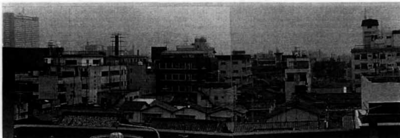
写真3 戦災復興地区（延焼した西代市場周辺の西端、1980年撮影） 木造モルタル戸建て住宅や木造アパート群が耐火造に囲まれている。 左側から中央の耐火造に延焼し、更に右側の木造家屋に延焼した。
